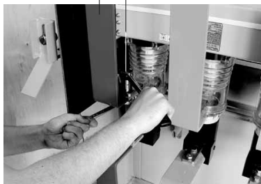
Рисунок 8.14 – Кріплення верхніх шин головних струмових кіл
