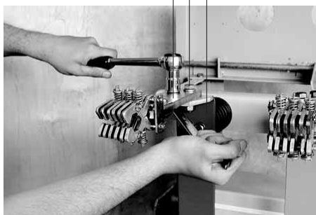
Рисунок 8.16 – Монтаж верхніх ШПК на шинах ВВ
