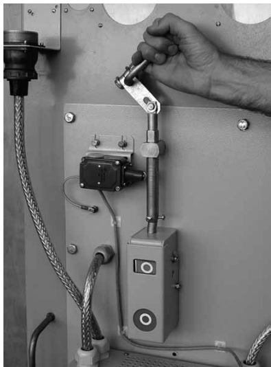
Рисунок 8.24 – Перевірка надійності роботи пристрою блокування
