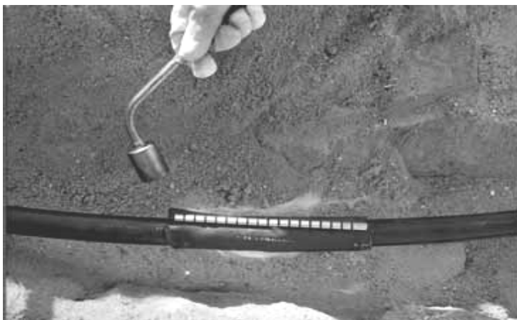
Рисунок 7.3 – Ескіз термоусаджувального манжета HDCW
