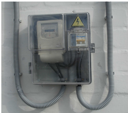
Рисунок 2.22 – Встановлення лічильника електричної енергії на вводі в будинок
