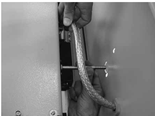
Рисунок 8.21 – Фіксація тяги в блокувальній тязі ВВ
