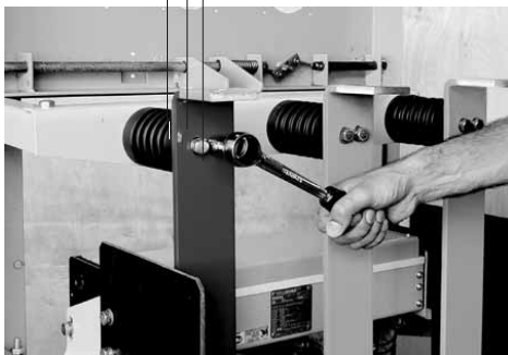
Рисунок 8.15 – Кріплення верхніх шин на опорних ізоляторах
