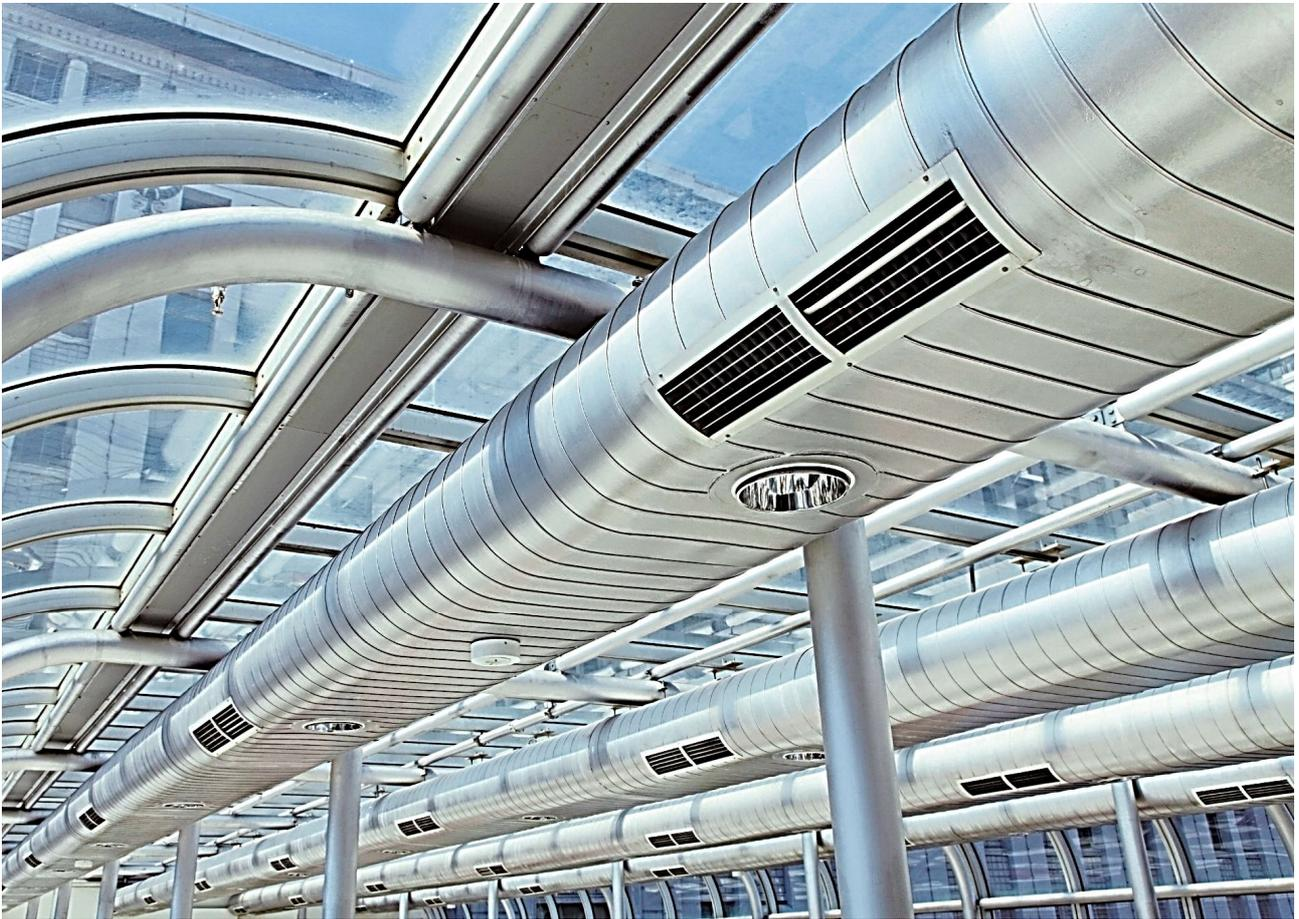
Рисунок 2.3 – Подавання припливного повітря в робочу зону
