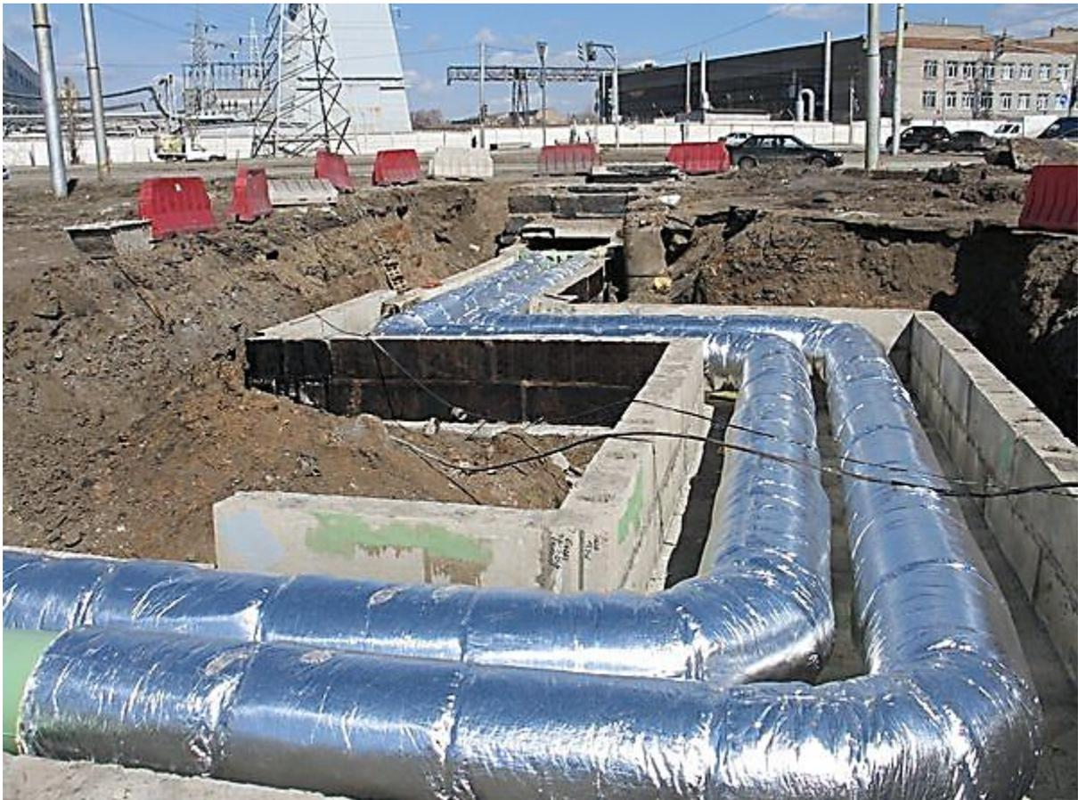
Рисунок 1.1 – Теплові мережі від централізованого джерела тепла
