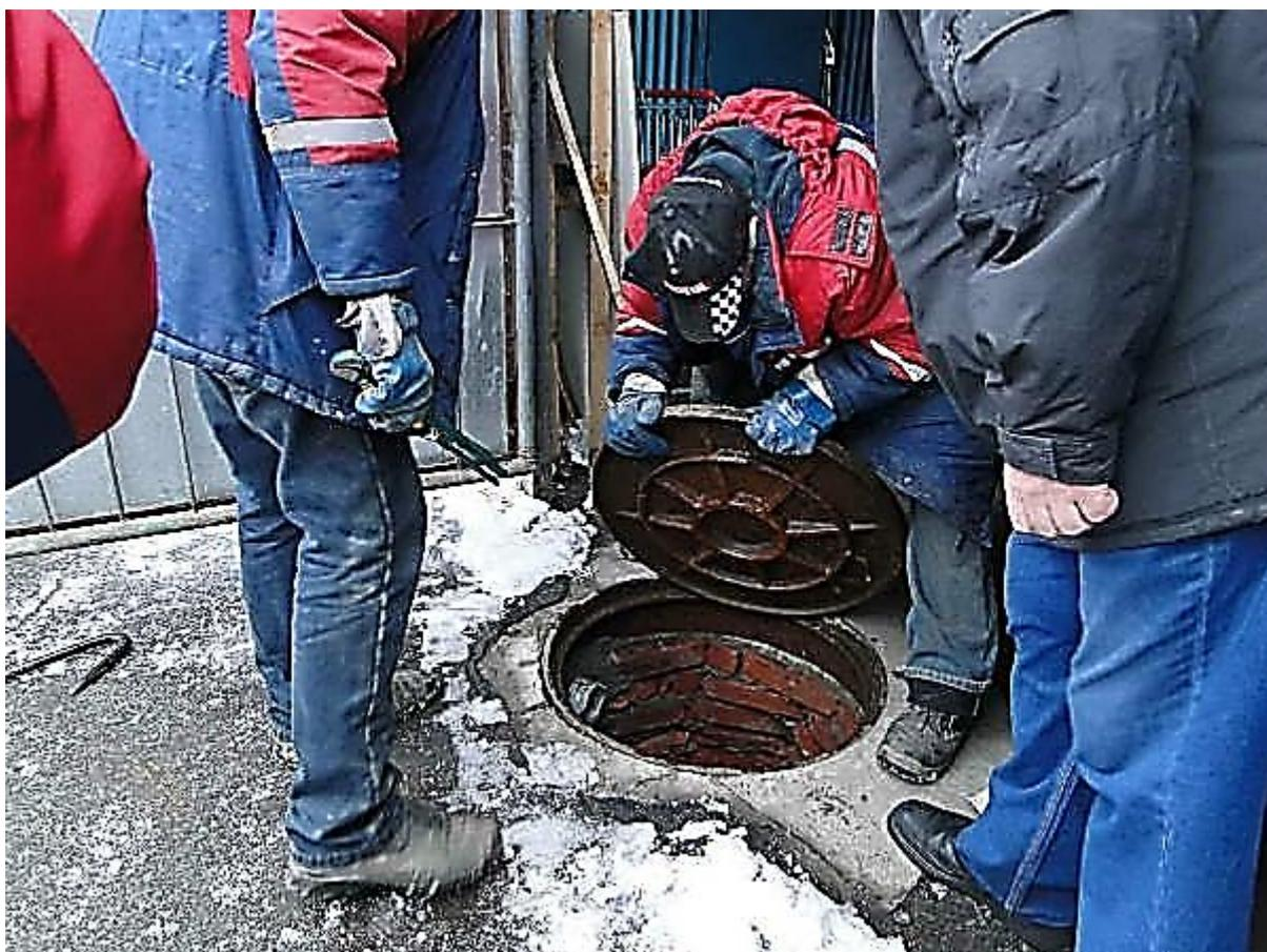
Рисунок 3.18 – Технічний огляд колодязів мережі водовідведення
