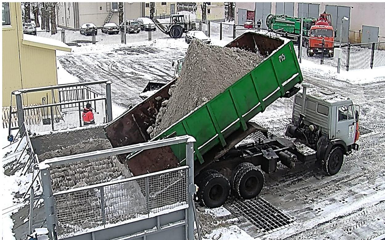
Рисунок 8.13 – Перероблення снігу на стаціонарному снігоплавильному пункті
