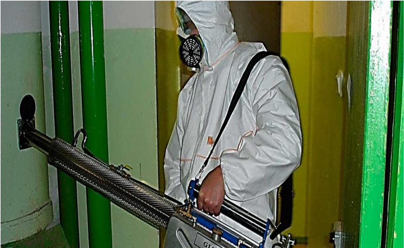
Рисунок 7.9 – Дезінфекція стовбура сміттепроводу
