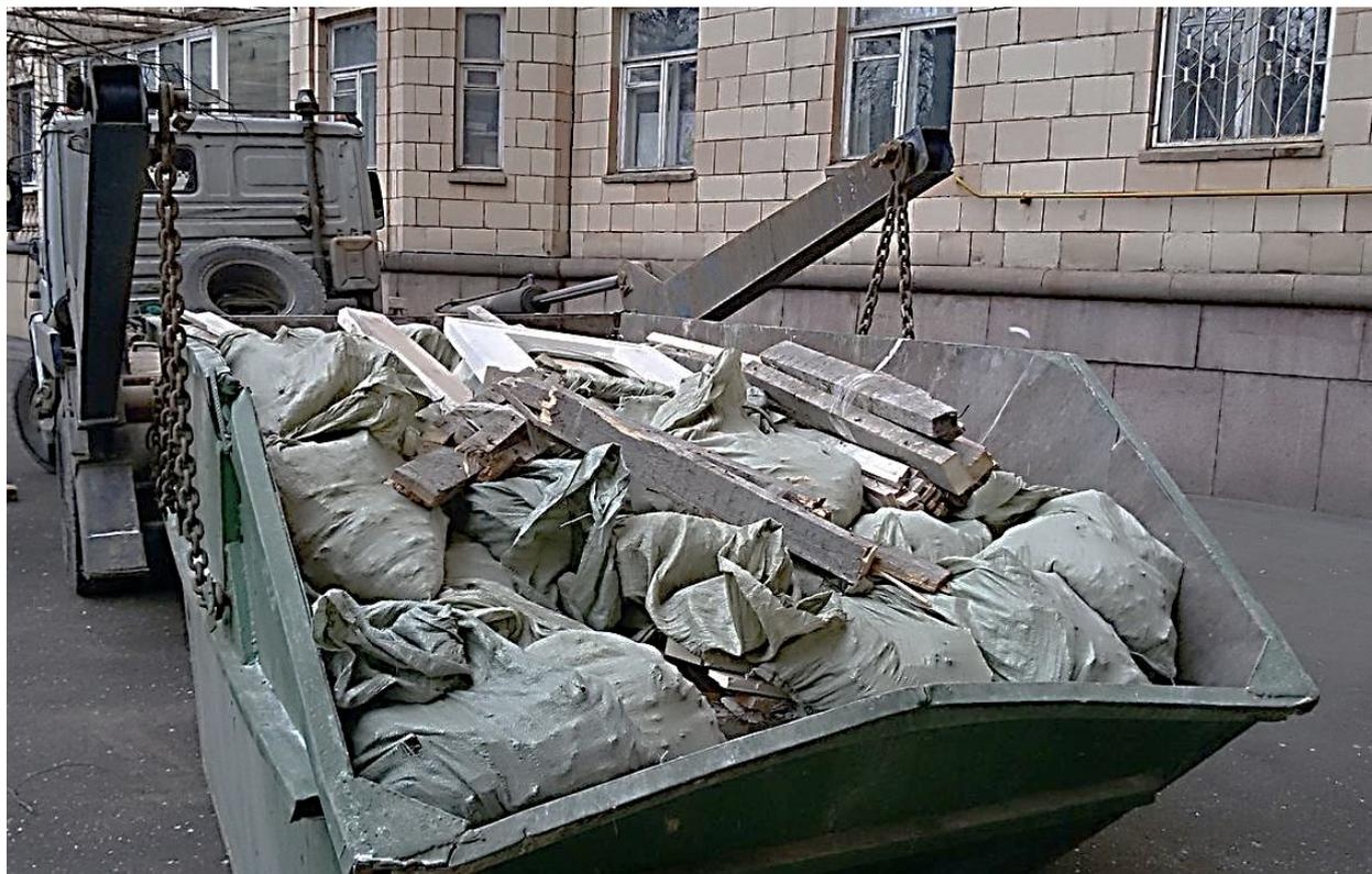
Рисунок 7.4 – Складування й вивезення будівельного сміття
