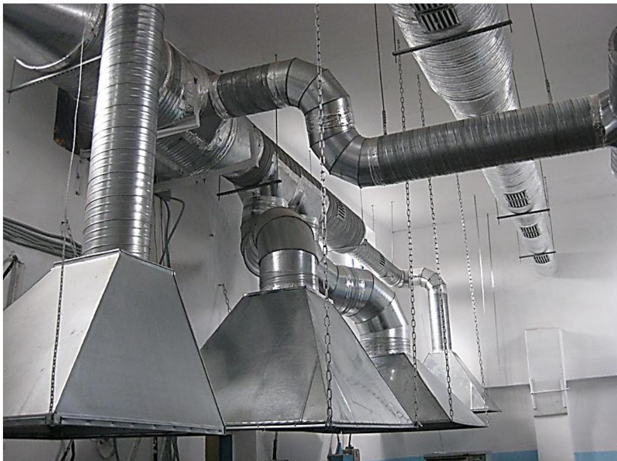
Рисунок 2.5 – Місцеві витяжні системи вентиляції
