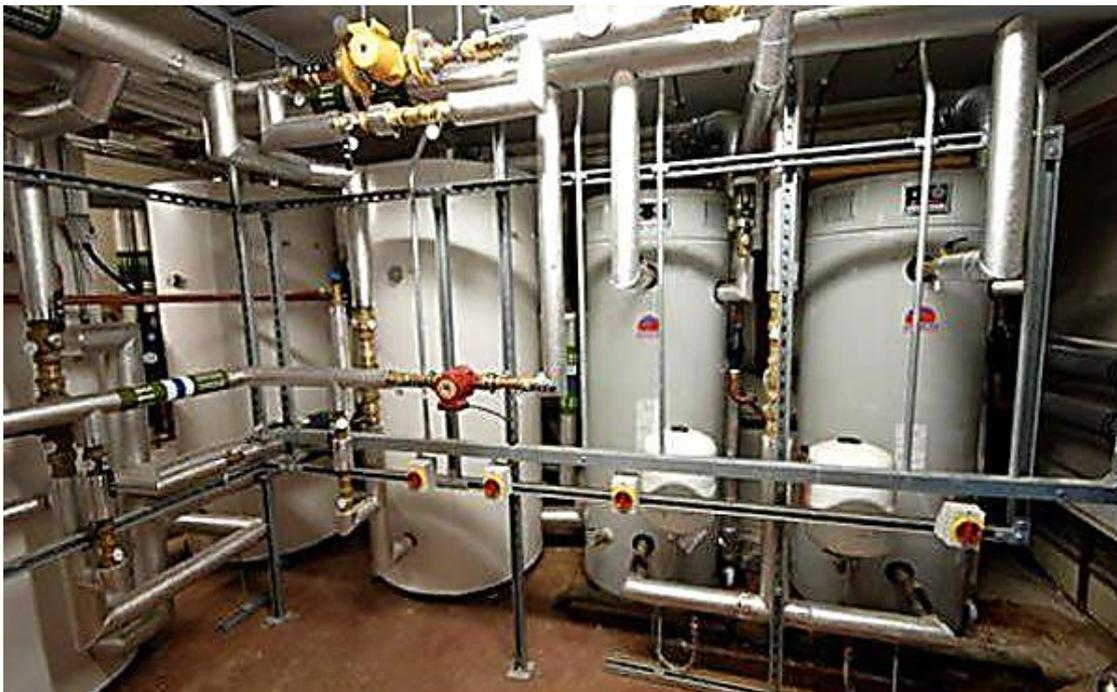
Рисунок 1.26 – Ємнісний водонагрівач
