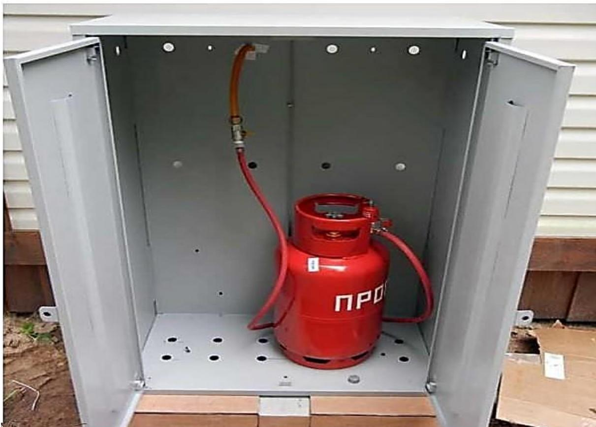
Рисунок 4.7 – Розміщення газового балона в шафі, що замикається
