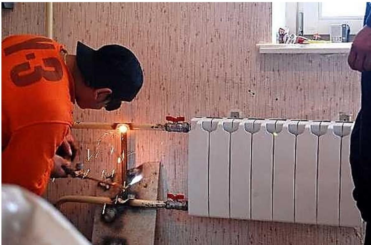
Рисунок 1.25 – Капітальний ремонт системи опалення
