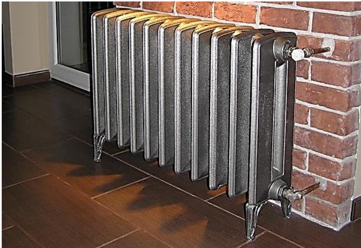
Рисунок 1.22 – Секційний радіатор
