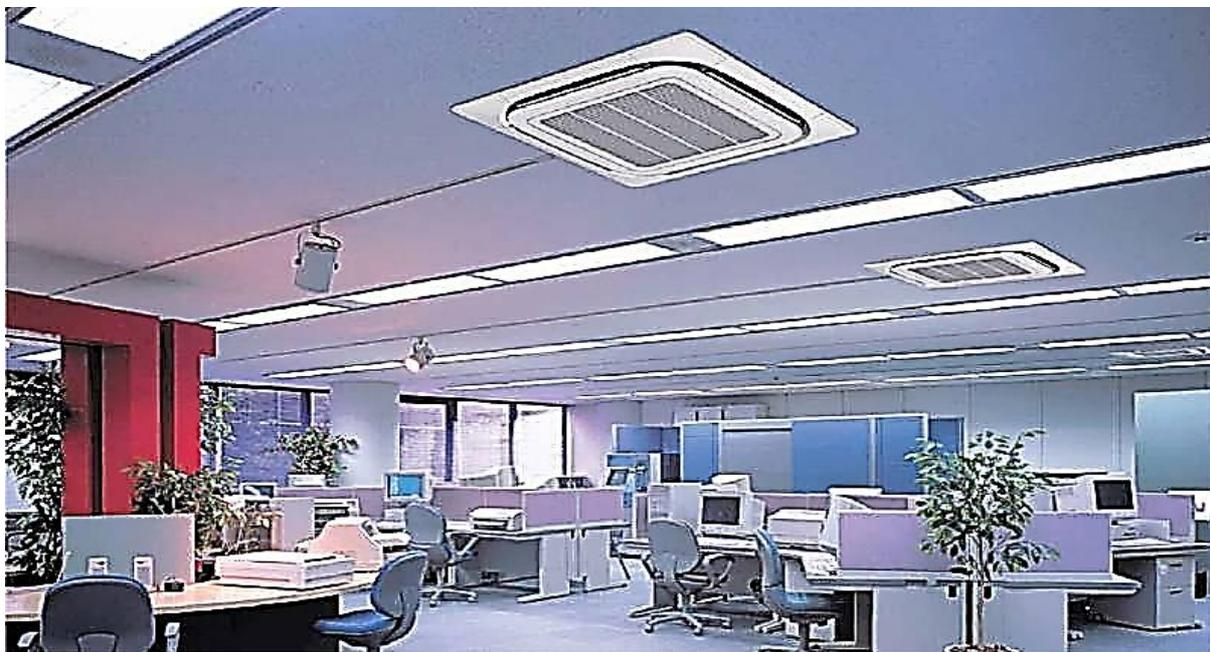
Рисунок 2.10 – Кондиціонери касетного типу
