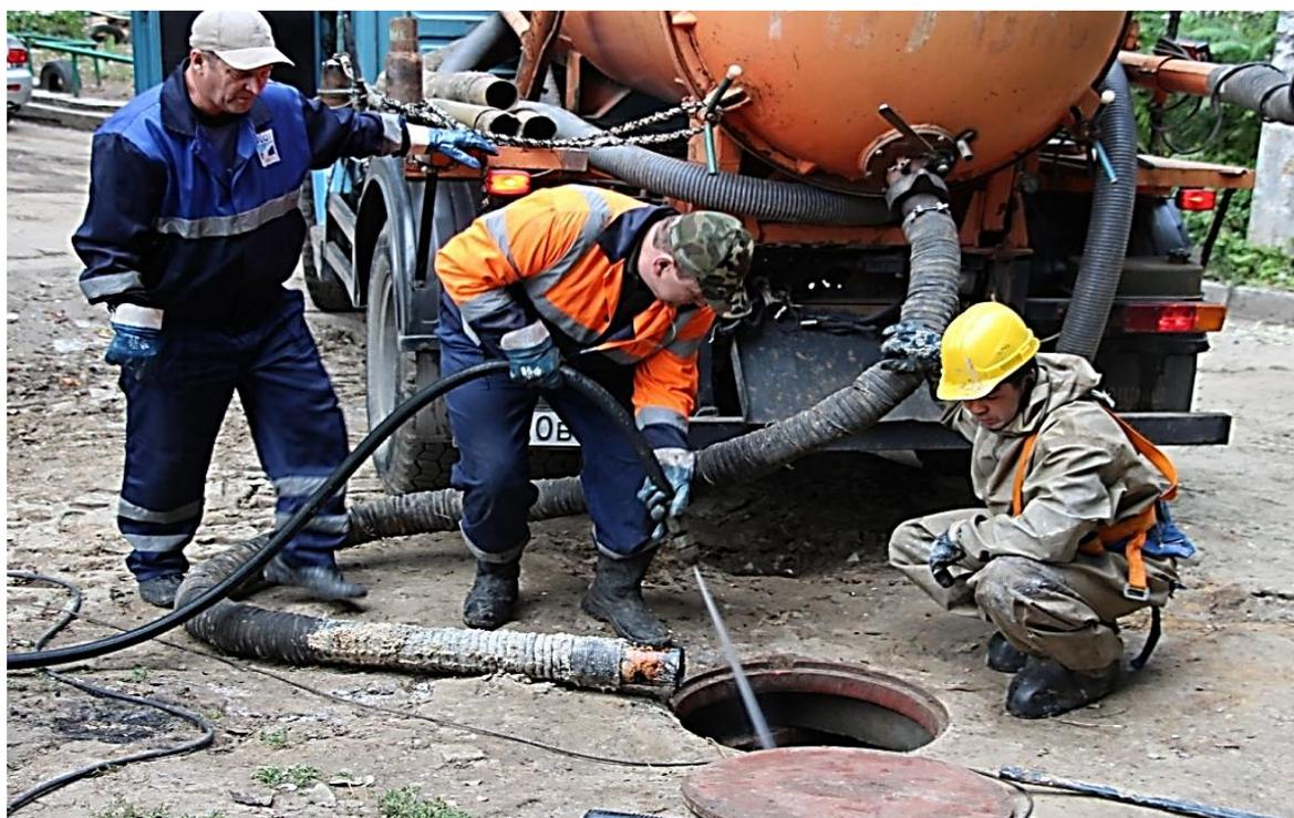
Рисунок 3.19 – Поточний ремонт мережі водовідведення
