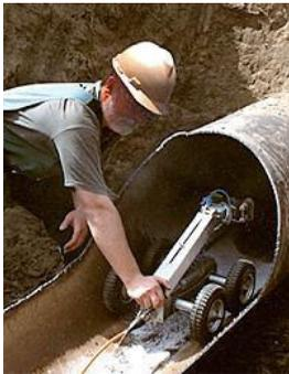
**Рис. 5.8. Запуск робота Р-200 в сталеву трубу через сідлоподібне вікно**
