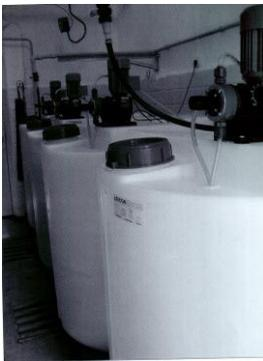
**Рис. 4.18.** Загальний вигляд дозаторної гіпохлорит натрію
