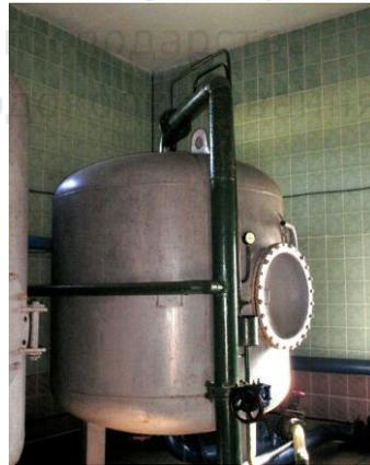
**Рис. 4.8. Напірний вертикальний фільтр**
