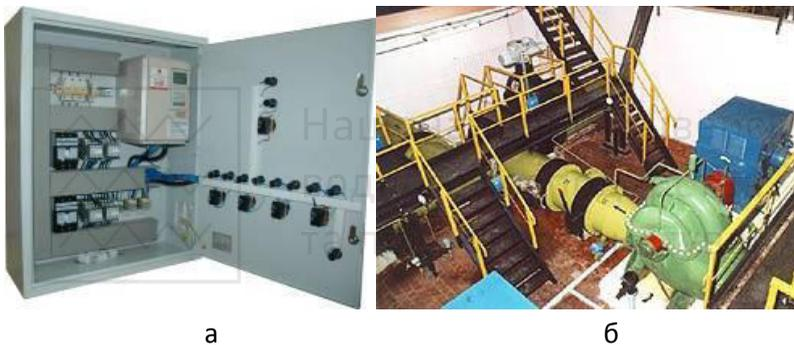
**Рис. 7.7. Станції управління насосами на підставі частотного перетворення:**
