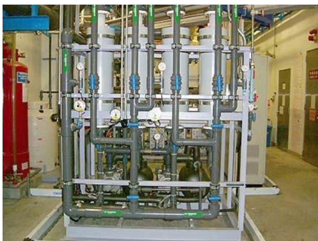
Рис. 7.22 – Установки мембранної дегазації
